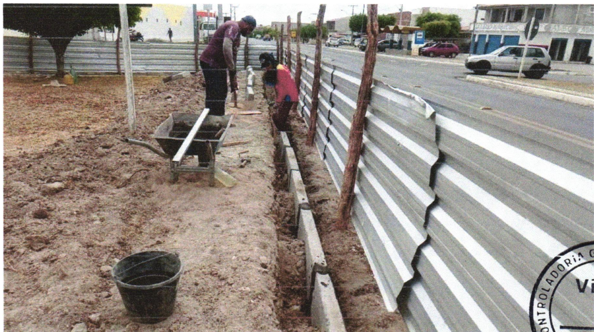
Foto 04 - ASSENTAMENTO DE GUIA (MEIO-FIO) EM TRECHO RETO, CONFECCIONADA EM CONCRETO PRÉ-FABRICADO, DIMENSÕES 100X15X13X20 CM (COMPRIMENTO X BASE INFERIOR X BASE SUPERIOR X ALTURA), PARA URBANIZAÇÃO INTERNA DE EMPREENDIMENTOS. AF_06/2016_P
