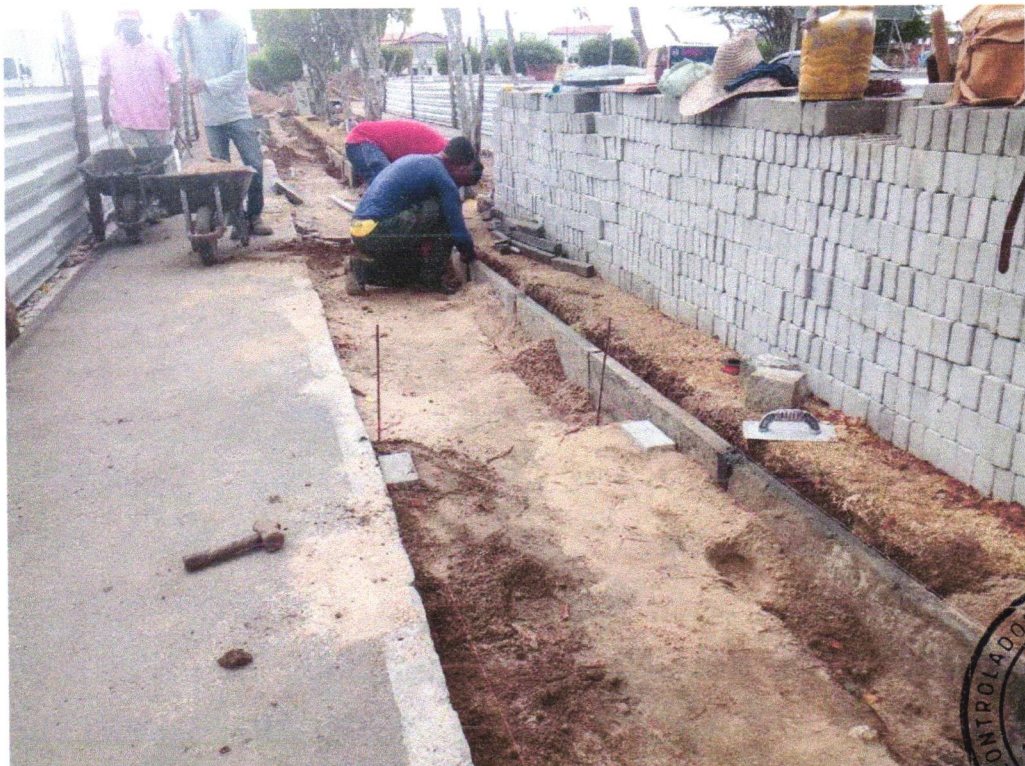
Foto 06 - ASSENTAMENTO DE GUIA (MEIO-FIO) EM TRECHO RETO, CONFECCIONADA EM CONCRETO PRÉ-FABRICADO, DIMENSÕES 80X08X08X25 CM (COMPRIMENTO X BASE INFERIOR X BASE SUPERIOR X ALTURA), PARA URBANIZAÇÃO INTERNA DE EMPREENHIMENTOS. AF_06/2016
