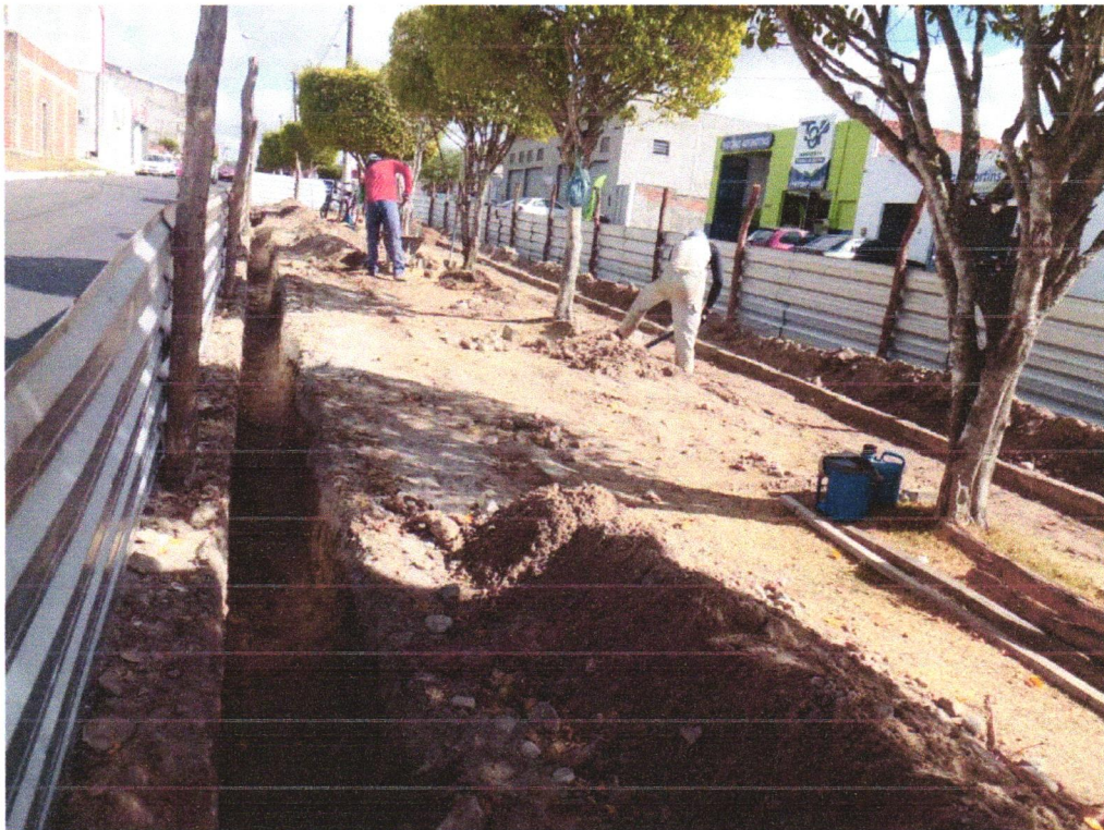
Foto 01 - ESCAVAÇÃO MANUAL DE VALA COM PROFUNDIDADE MENOR OU IGUAL A 1,30 M
