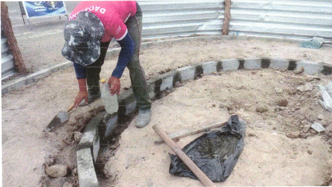
Foto 05 - ASSENTAMENTO DE GUIA (MEIO-FIO) EM TRECHO CURVO, CONFECCIONADA EM CONCRETO PRÉ-FABRICADO, DIMENSÕES 100X15X13X20 CM (COMPRIMENTO X BASE INFERIOR X BASE SUPERIOR X ALTURA), PARA URBANIZAÇÃO INTERNA DE EMPREENHIMENTOS. AF_06/2016_P
